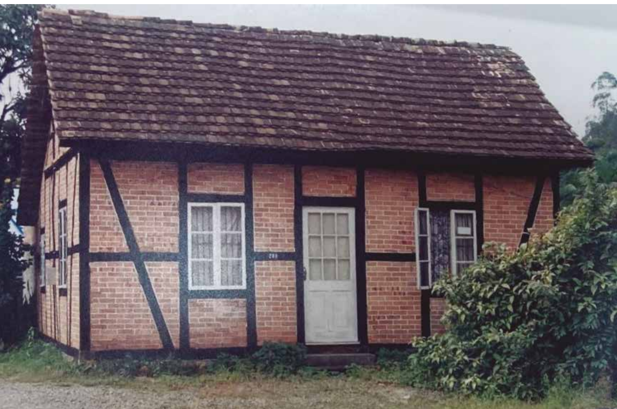
Figura 18 – Casa em técnica enxaimel, na Rua General Valgas Neves, 281
