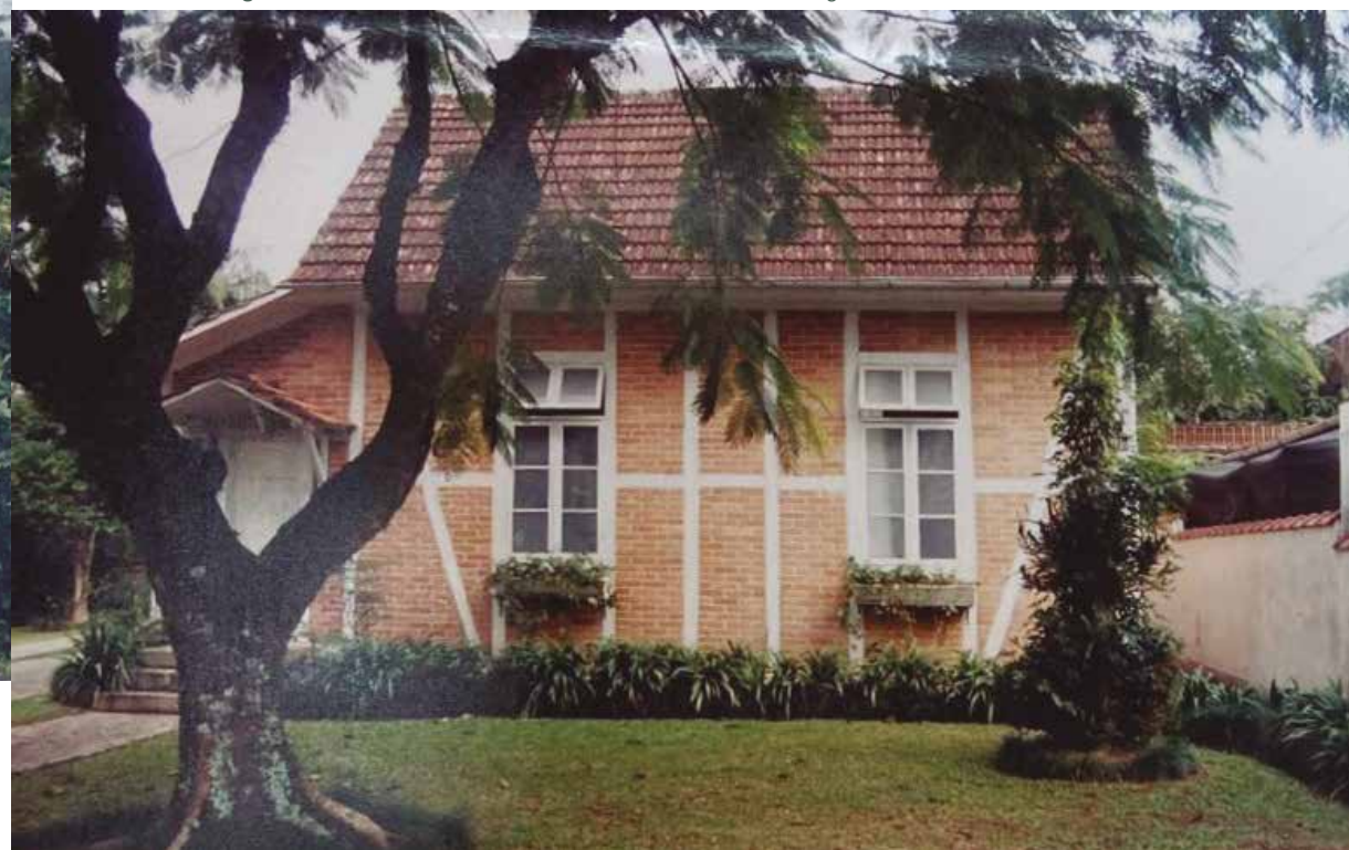
Figura 19 – Casa em técnica enxaimel, na Rua General Valgas Neves, 458
